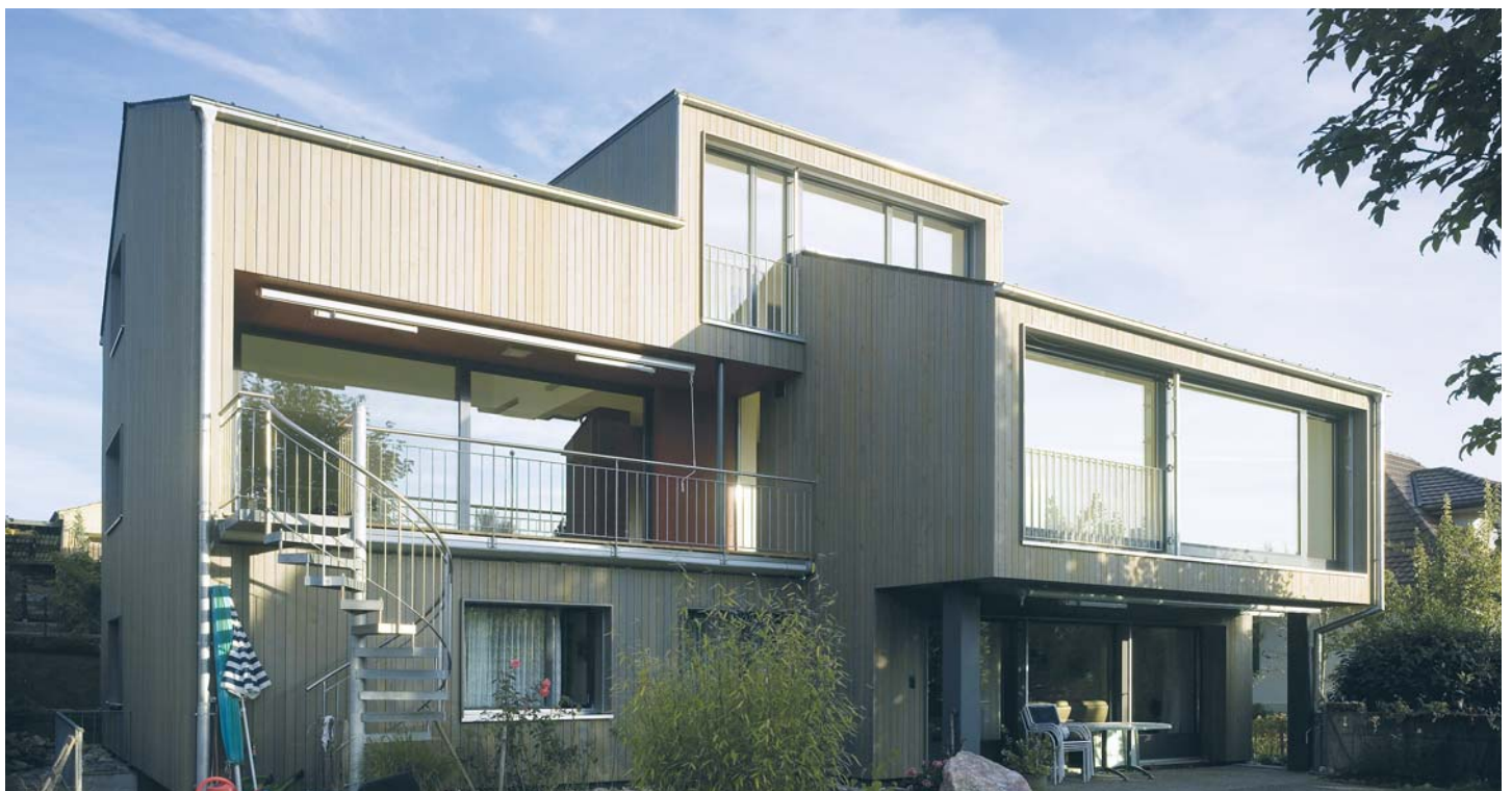
Nach dem Umbau
