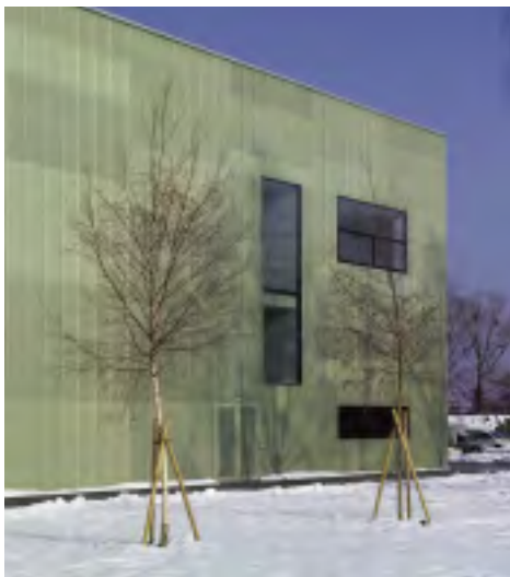
Fassadenarbeiten mit Polyesterplatten, Firma Raumbau, Hard
