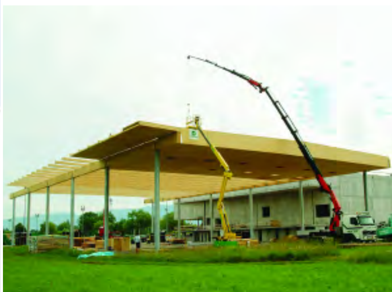
Montage der Eislaufplatzüberdachung in moderner Holzbauweise, Firma Dobler Bau GmbH, Röthis
