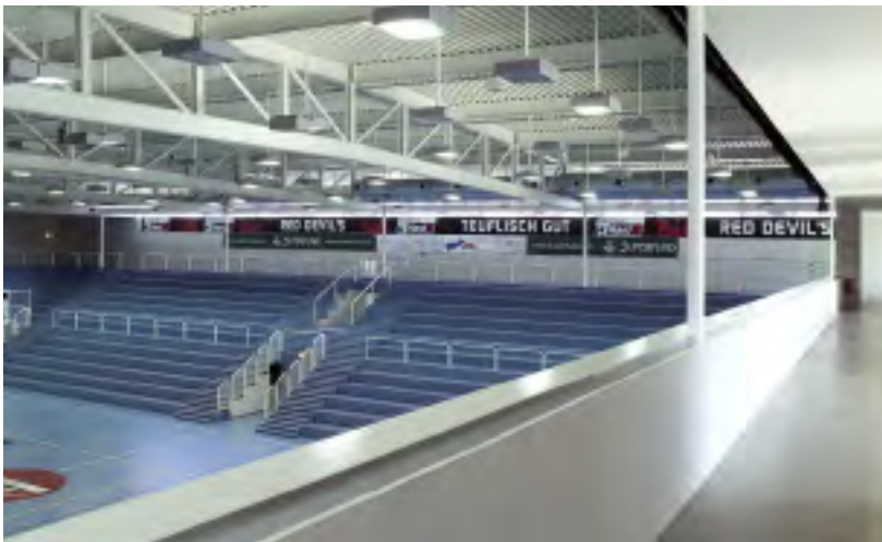
Stahlkonstruktion der Firma Chrysanth Thaler Stahlbau GmbH & Co KG
