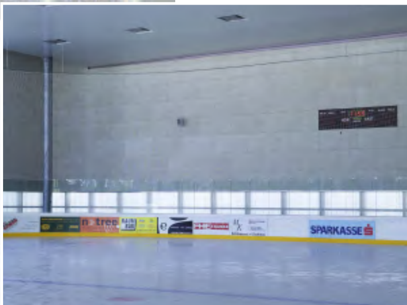
Lärmschutzwand der Firma Roda GmbH, Lustenau
