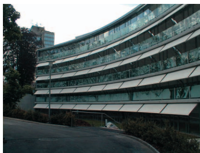
Überbauung „Bahnhof Süd“ Aarau: Zwei grosse Wärmepumpen liefern 110 kW für die Heizung, Baujahr 2002. Die Erdsondenanlage wird im Sommer für „Natürliches Kühlen“ genutzt. (Bild SATAG).
